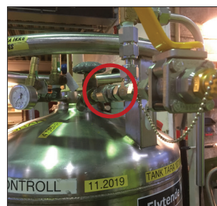
Trykkavlaster tilkoblet ventil 4
